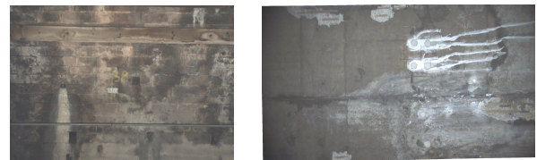
FIGURE 1 – Exemples d'images du piédroit d'un tunnel en maçonnerie (à gauche) et de la clé de voûte d'un tunnel en béton (à droite)
